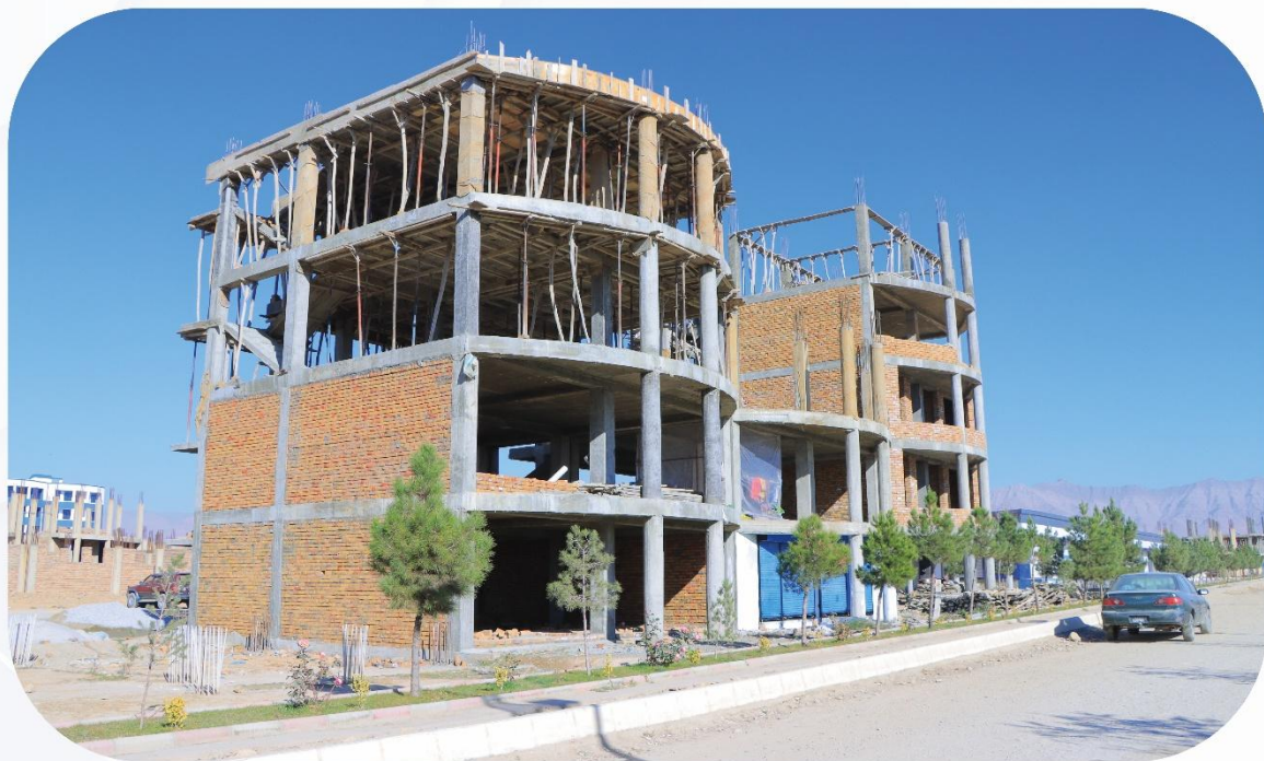
بلاک های در حال ساخت در منطقه A
