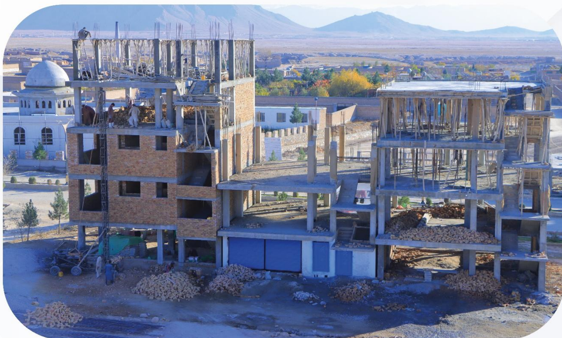
بلاک در حال ساخت در منطقه A
